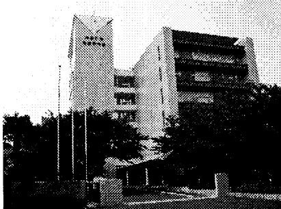
国道1号線からの全景
